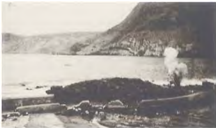
Uso de explosivos na demolição de construções existentes na baía do Tarrafal.
