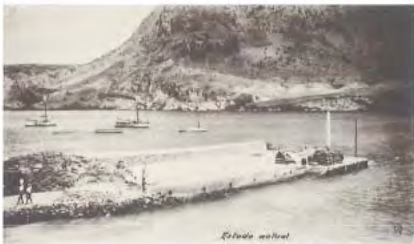
Para a construção do campo, foram efectuadas diversas intervenções preparatórias, designadamente a reparação do cais de embarque do Tarrafal.
