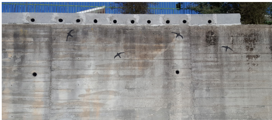
FIGURA 1. Locais de nidificação no muro da escola.
